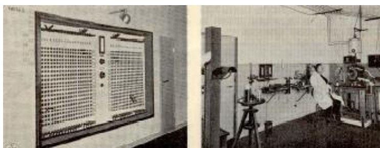
Instalaciones del Rockefeller ( Siemens 2 , 1934)
