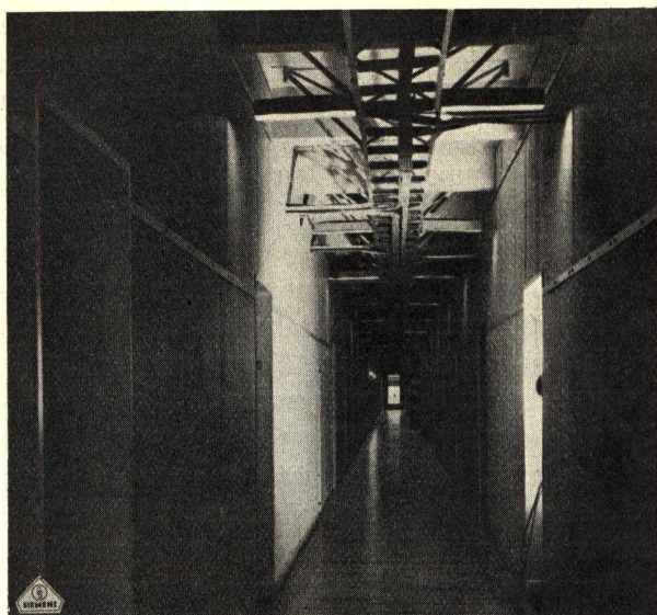
Fig. 9. Tendido de conductores de experimentación.
